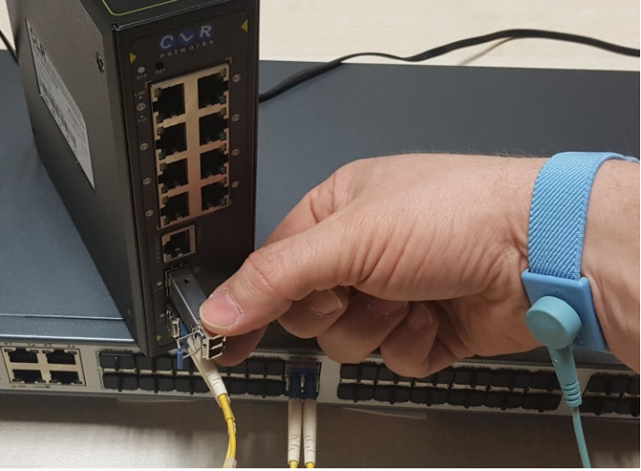
Resim 6. SFP modülün yuvaya yerleştirilmesi
